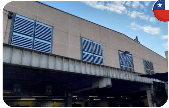
Atenuadores para sala de máquinas Cencosud
