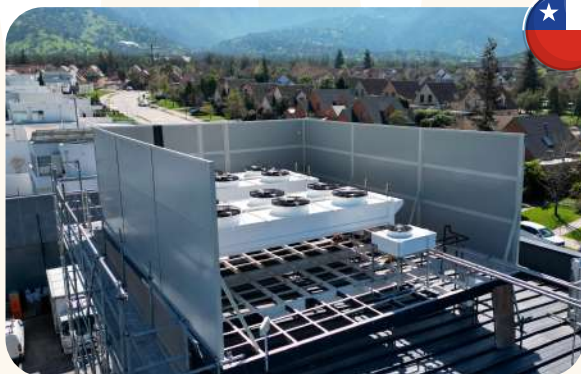
Barreras acústicas para equipos HVAC Cencosud
