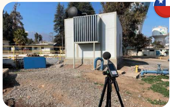
Encierro acústico para Generador Eléctrico Aguas Andinas
